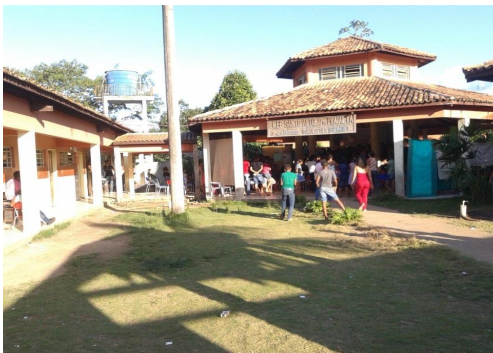
Figura 30: Escola M. E. F Santo Antônio do Praialta, construída através do projeto Alvorada
