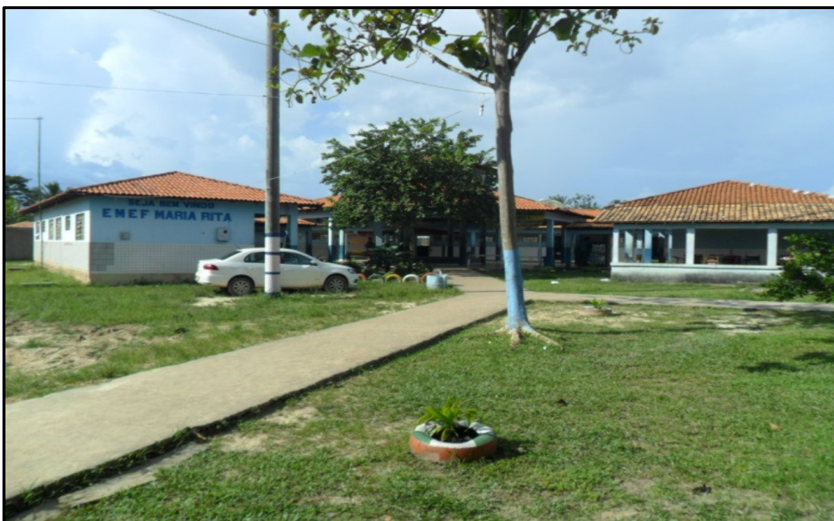
Figura 05: Novo prédio da Escola. Fonte: Simão Ramos, 2014.
