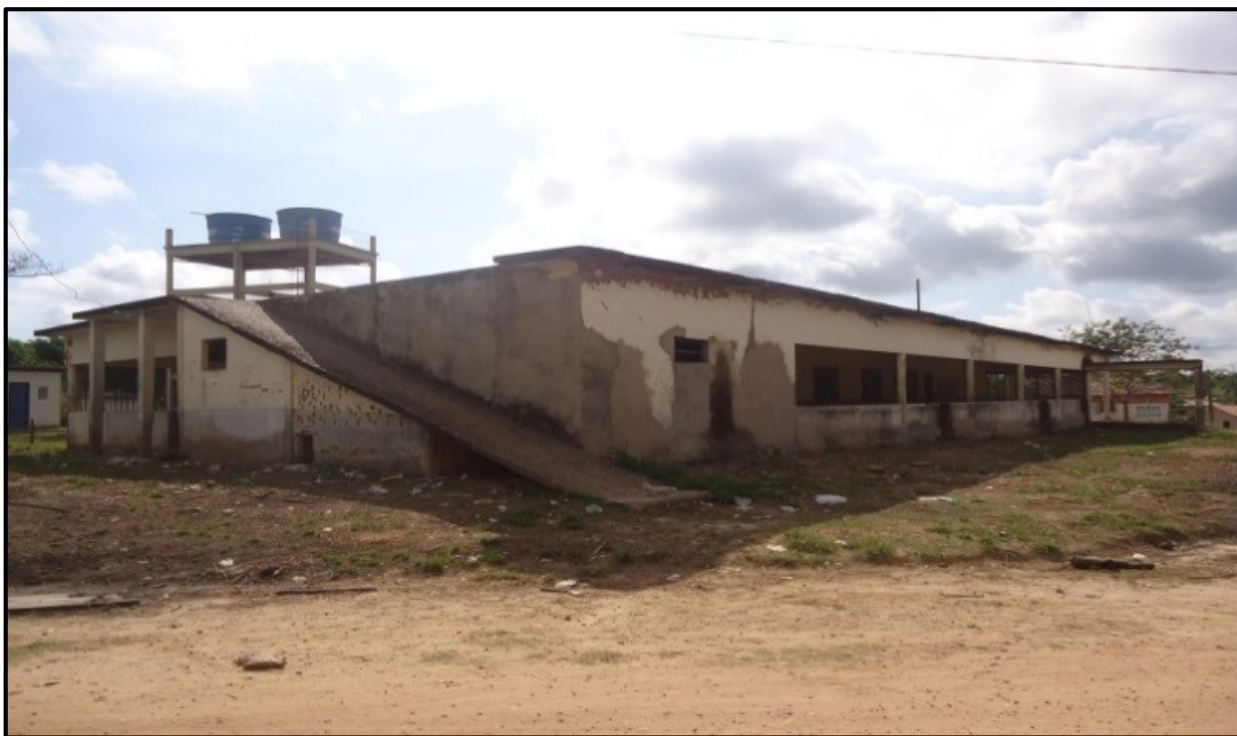
Figura 04: Sede da fazenda que funcionava como Escola Fonte: Simão Ramos, 2014.
