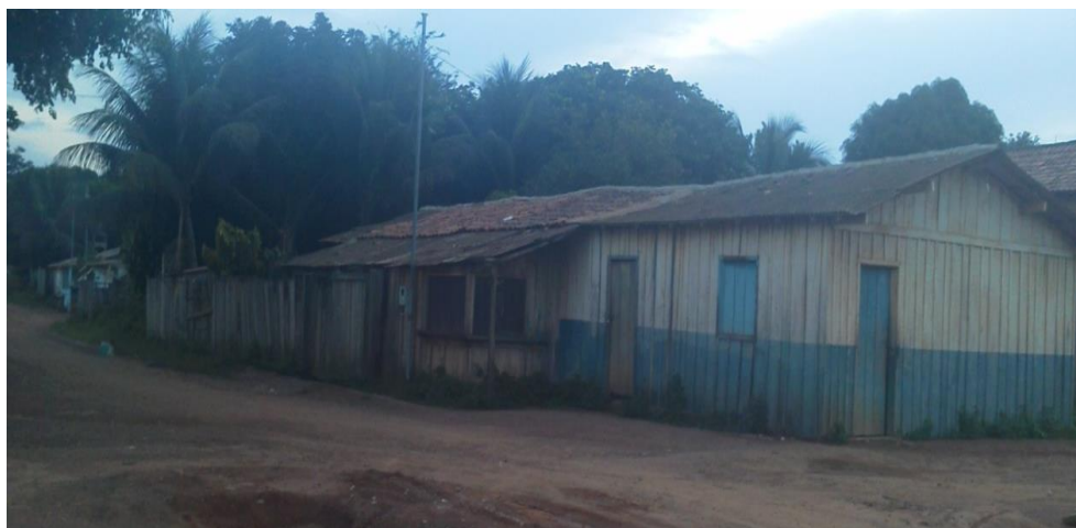
Foto 13 - Anexo da Esc. Adão Machado Fonte: Nascimento 2012
