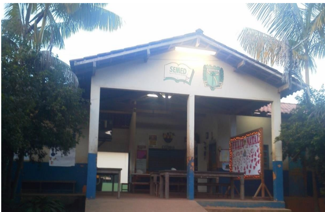
Foto 12 Escola Adão Machado - Nova Estrutura Fonte: Nascimento 2014
