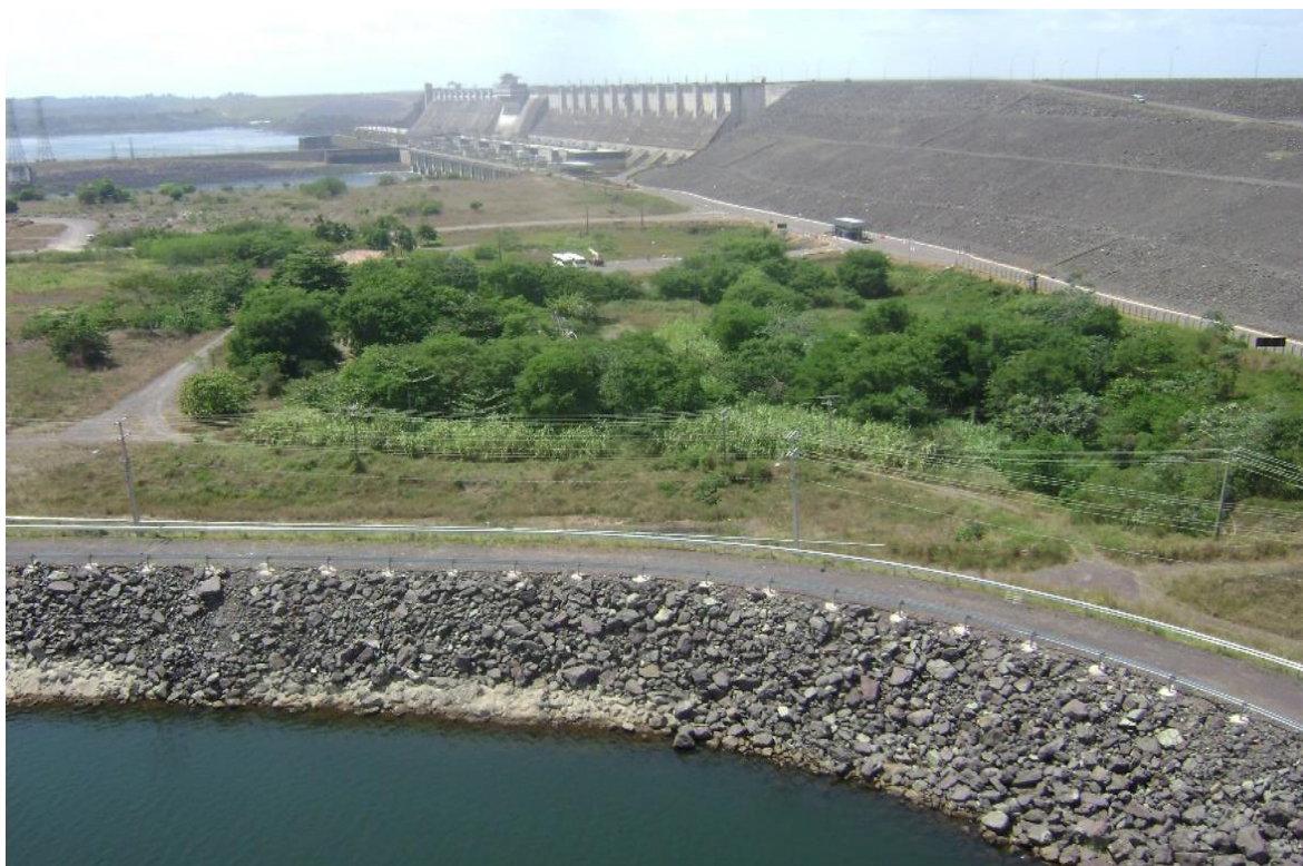
Foto 6: Usina Hidrelétrica de Tucuruí, operada pela Eletronorte.
