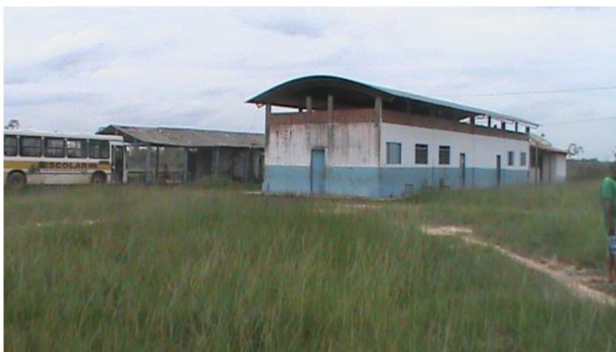
Foto 6: Fachada da escola, após transição para assentamento
