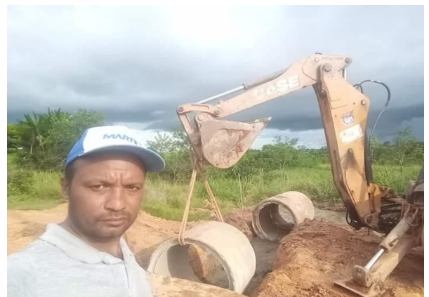
Figura 3: Vereador Tutu acompanhando os trabalhos de instalação de bueiros
