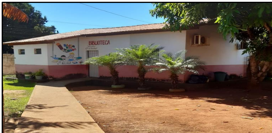
Figura 9 - Espaço externo prédio que funciona a biblioteca da Escola Municipal Antônio de Assis. Fonte: Acervo pessoal, 2019.
