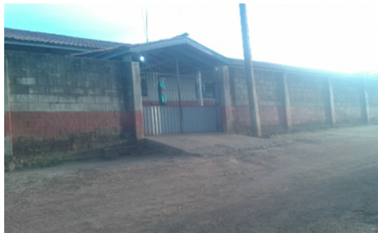
Figura 5. Construção da Escola Nossa Senhora das Dores em alvenaria
