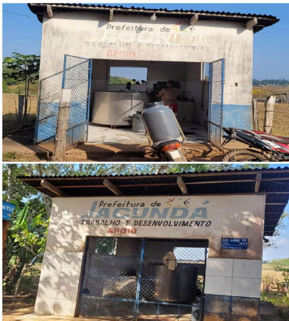
IMAGEM 07 - Resfriadores de leite - Vila Limão
