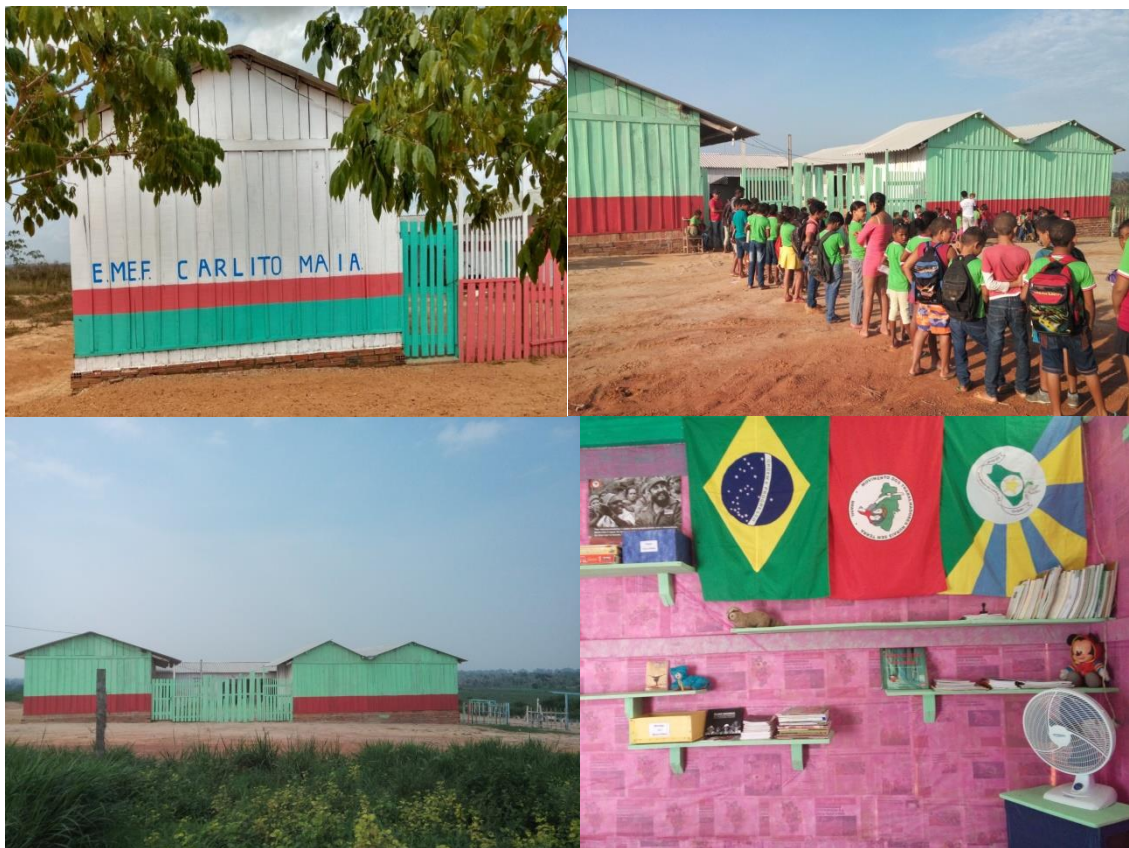
Figura 10. Imagens da estrutura da Escola Carlito Maia. Créditos: Autora, 2023.
