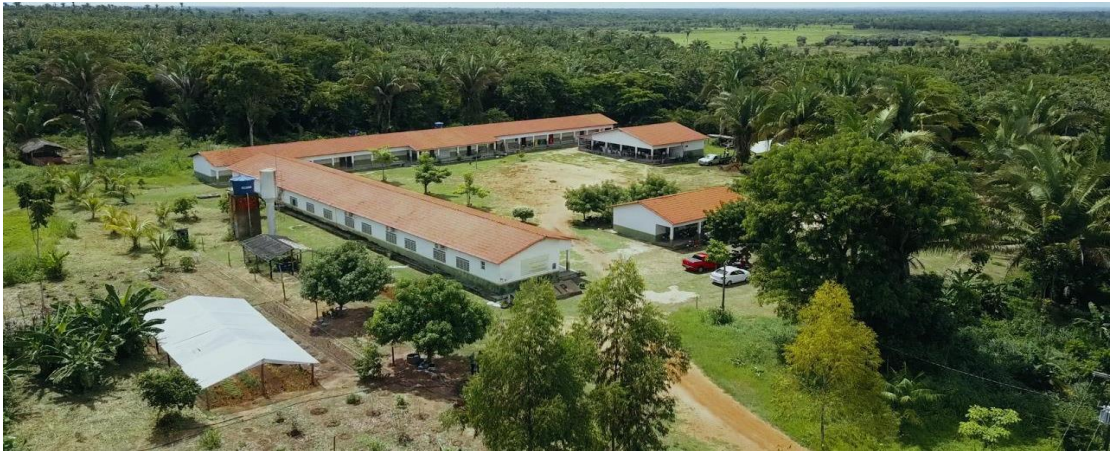
Figura 6 - EFA Padre Josimo construída na área doada pela Associação dos Agricultores do Projeto de Assentamento Mulatos.
